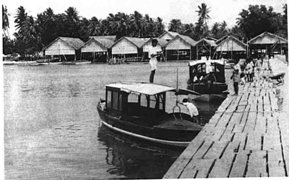
Jeti dan rumah perahu daripada kayu, Pulau Home, 1945 (Ihsan: A.de Groot, U.K.)
